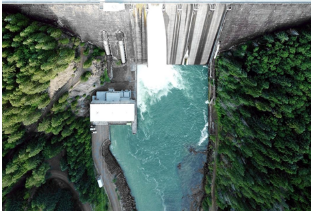
Obraz 16: Detroit Dam, Detroit, Oregon, Stany Zjednoczone - Zdjęcie Dan Meyers
